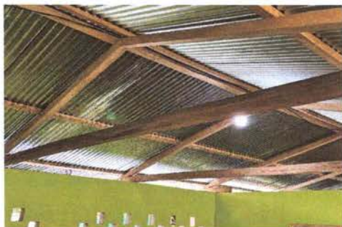
muestra la estructura de madera en una de las aulas
